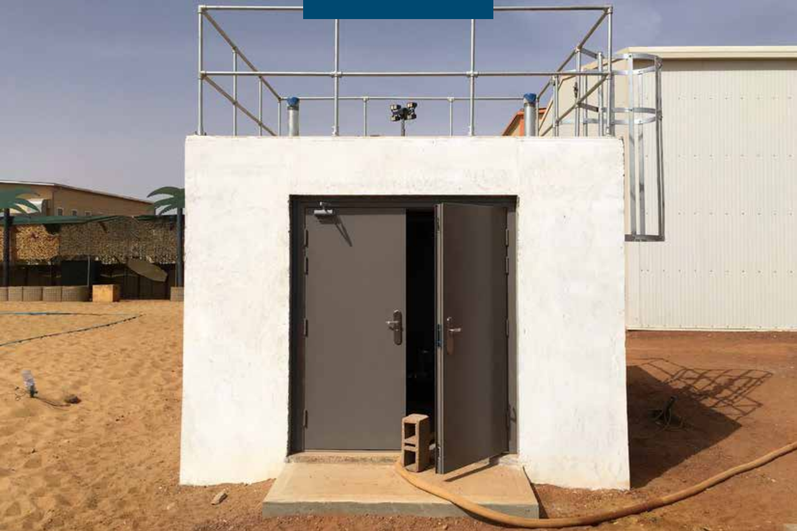
△ Abb. 2: Beispiel einer Brunnenstube im Camp Castor Quelle: ZGeoBw/Evssev
