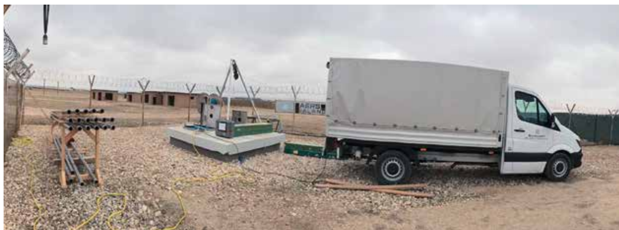
△ Abb. 3: Beispiel einer Brunnenstube Quelle: ZGeoBw/Görke
