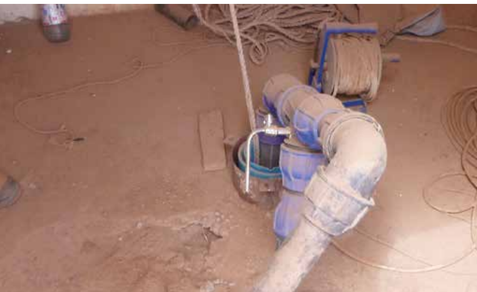
△ Abb. 1: Alter Zustand des Brunnen Quelle: ZGeoBw/Evssev
