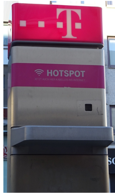
Abb. 6: Bereits seit Längerem übliche Mikrozelle der Telekom mit LTE-Mobilfunk (Hotspot) in einer Fußgängerzone
