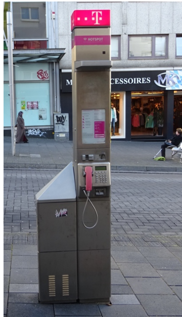
Abb. 6: Bereits seit Längerem übliche Mikrozelle der Telekom mit LTE-Mobilfunk (Hotspot) in einer Fußgängerzone
